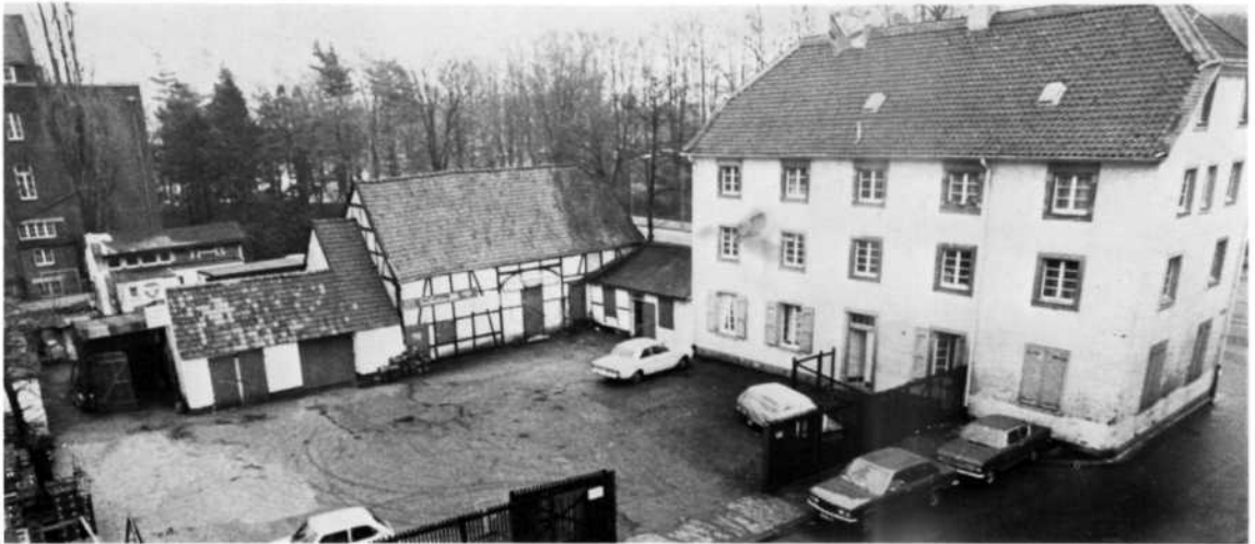
Haus Spilles vor der Renovierung
